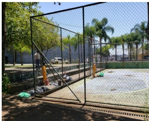
Figura 47: Manutenção na quadra
