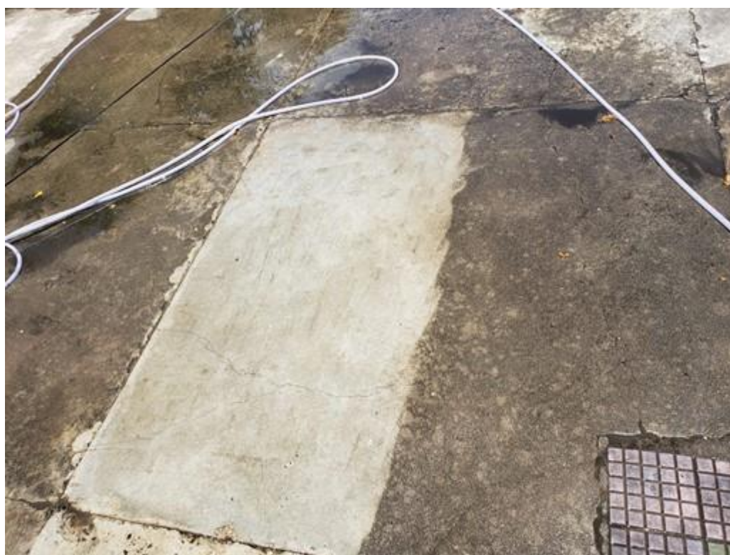
Figura 39: Limpeza do piso com lavadora de alta pressão
