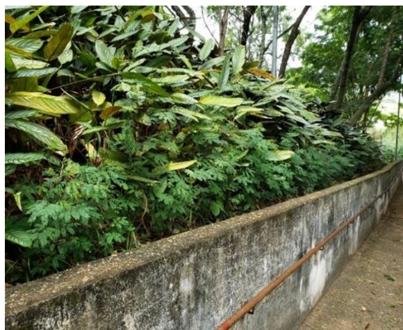
Figura 22: Jardim antes do despraguejamento
