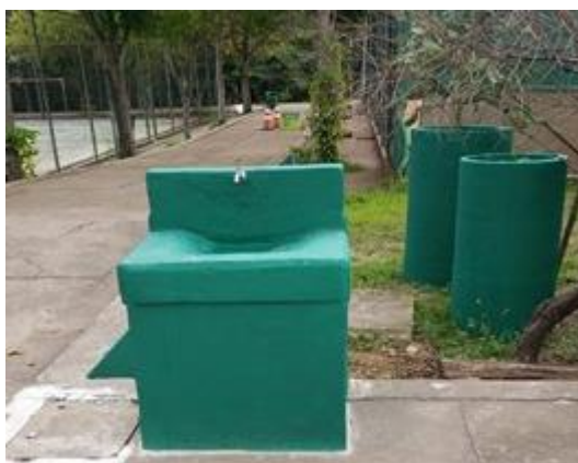
Figura 40: Execução de pinturas
